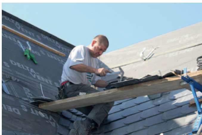
Neue Dacheindeckung mit Naturschiefer
