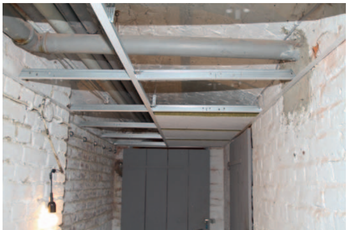
Unterkonstruktion Kellerdecken-Isolierung
