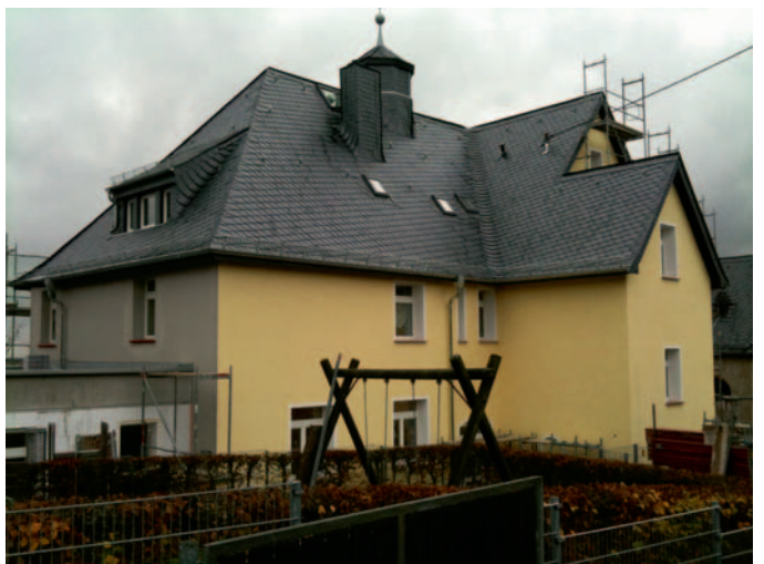
Das Dach ist fertig neu eingedeckt, die neuen Fenster eingebaut, die Fassade wärmedämmend und neu gestrichen – nur noch Restarbeiten (z.B. am Kindergarten-Flachdach-Anbau) müssen erledigt werden.
