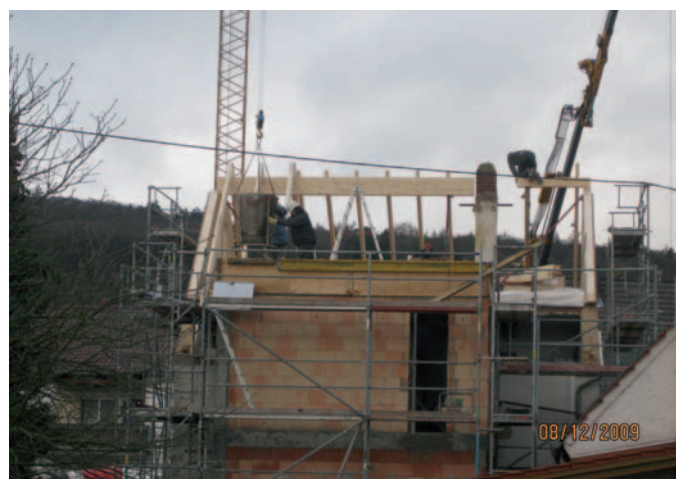
Das neue Dach entsteht
