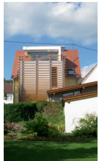
Hinterer Treppenhausanbau mit Holzfücher und Dachterrasse
