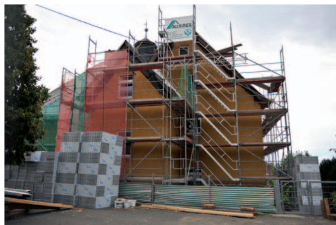
Das Wärmedämm-Material für die Fassade liegt bereit
