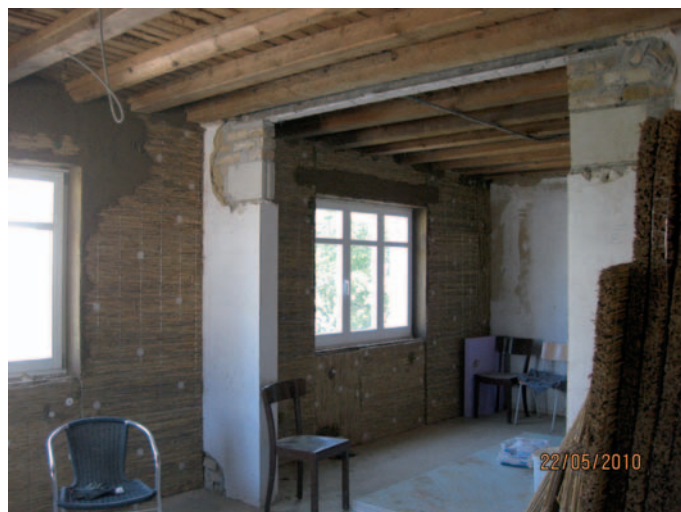
Die Schilfrohmatten zur Wärmedämmung werden eingebaut
