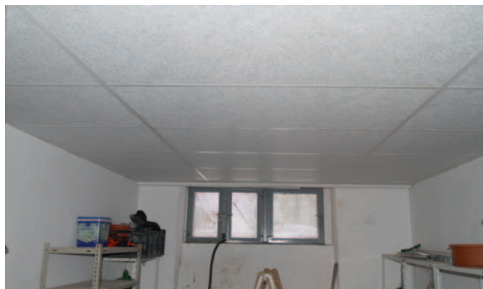
Fertige Decken-Wärmeisolierung im Kellerbereich
